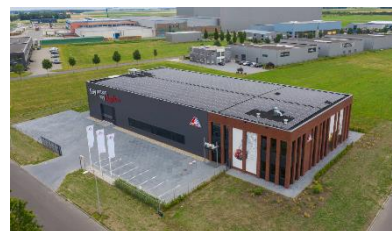
Foto 8.3 Luchtfoto Agrico Quality Center
