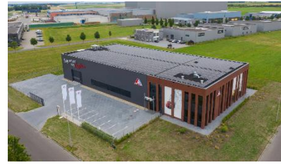
Foto 7.3 Luchtfoto Agrico Quality Center
